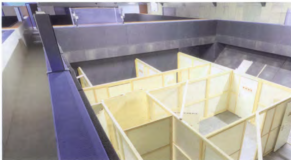
Figuur 11: De inrichting van de oefenruimte van het schiethuis, blik vanaf de catwalk. Duidelijk zichtbaar de buitenwanden voorzien van rubber platen, tussenwanden van hout en vinyl, betonnen catwalk met kunststof veiligheidsplaten. (Foto: Nationale Politie)
